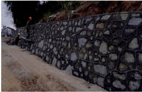
图为:龙坡水施工现场
