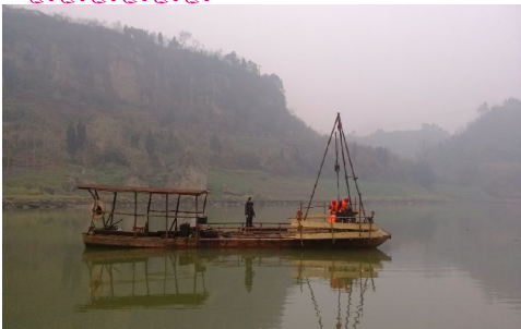
图为:钻机在江中施工
